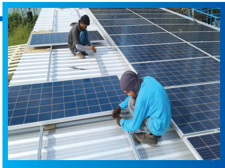
โครงการติดตั้งพลังงานแสงอาทิตย์ จำนวน ๒๕ กิโลวัตต์แบบออนกริด
