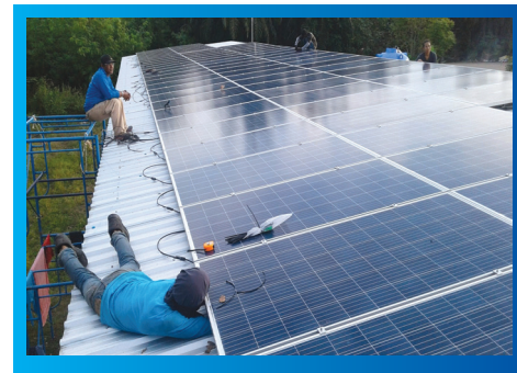
โครงการติดตั้งพลังงานแสงอาทิตย์ จำนวน ๒๕ กิโลวัตต์แบบออนกริด
